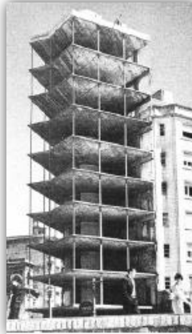
Foto 3 - El Pilar en obras de construcción
