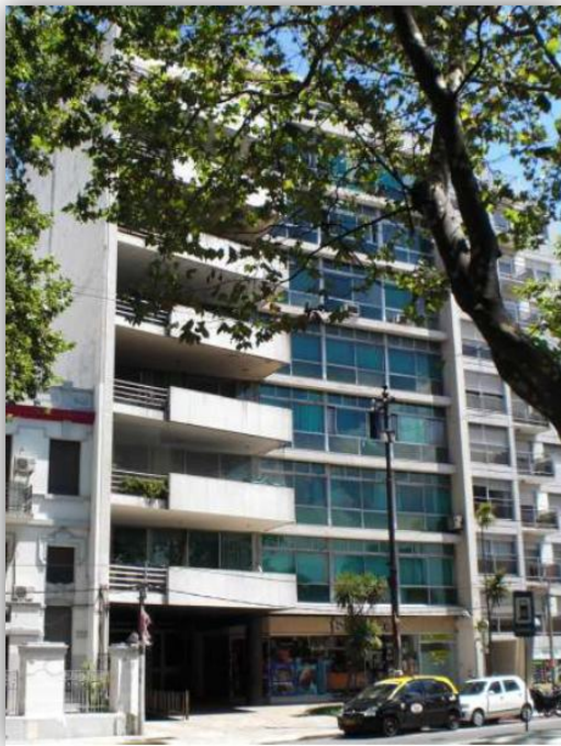
Foto 10 - Edificio Gilpe, año 1955 (Av. Brasil, 2574)
