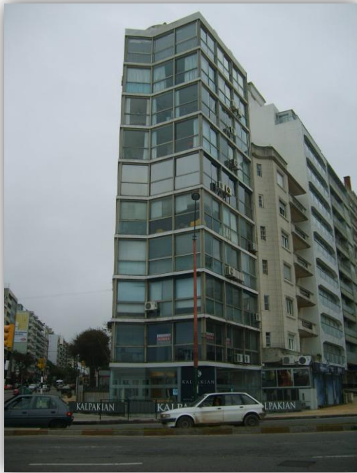
Foto 2 - fachada del edificio desde la rambla
