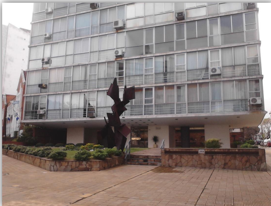
Foto 1 – entrada al Edificio Positano
