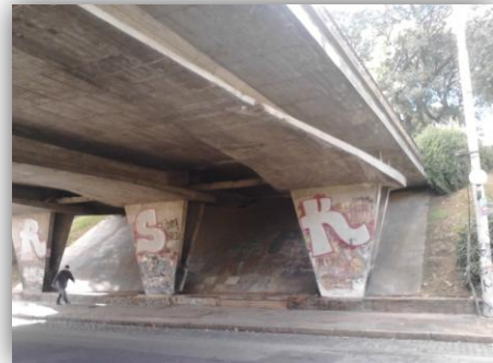
Foto 21 - Puente sobre Av. Sarmiento, Montevideo (arco de tres articulaciones)
