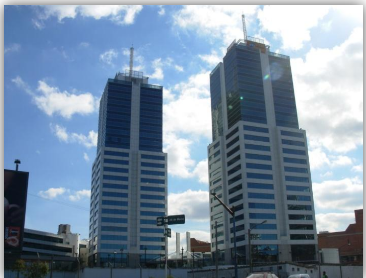
Foto 4 – Fachada con Curtain Wall: World Trade Center, Montevideo, Uruguay
