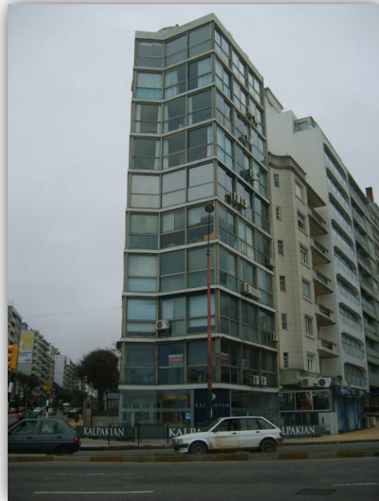
Foto 19 - Edificio El Pilar, año 1957 (Bvar. España 2997 esquina Av. Brasil y Rambla)
