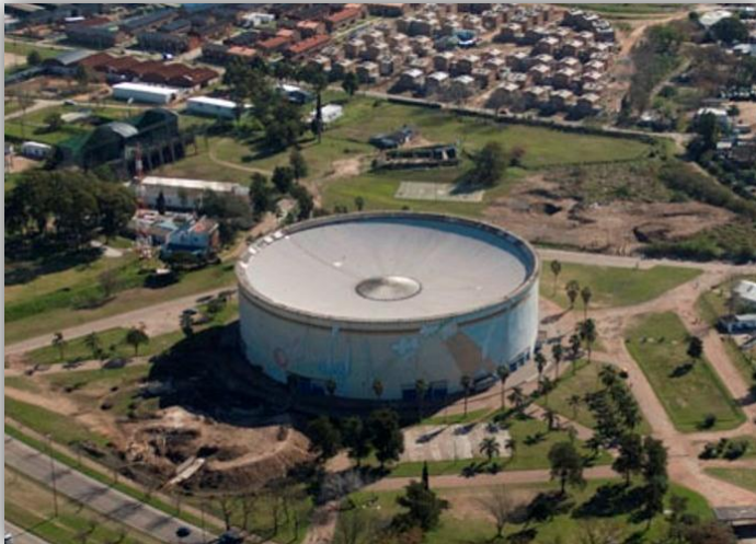
Foto 20 - Cilindro Municipal, Montevideo (techo de hormigón pretensado)
