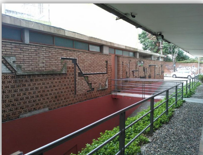
Foto 7 - Murales sobre la entrada al estacionamiento del edificio
