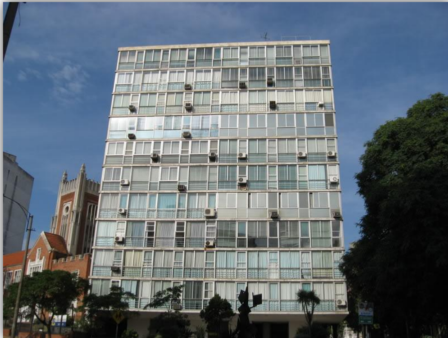
Foto 3 - fachada de vidrio y aluminio del edificio Positano
